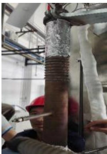
更换铠装加热电缆过程
