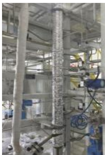
完成铠装加热电缆
