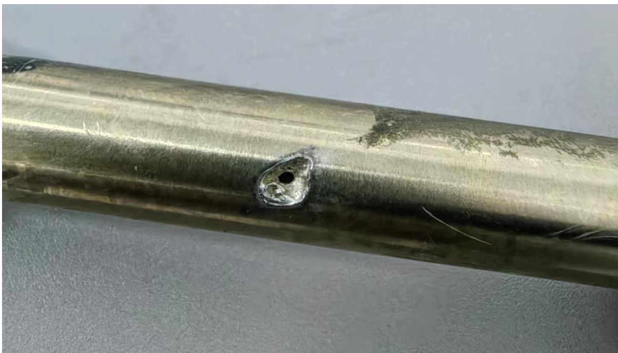
图 6 乙醇管道穿孔
